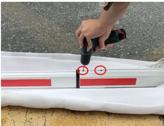
图2-6 杆件打孔示意图
