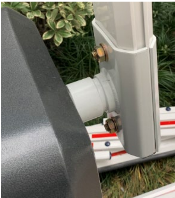
图2-2 直杆带胶条闸杆安装图片
