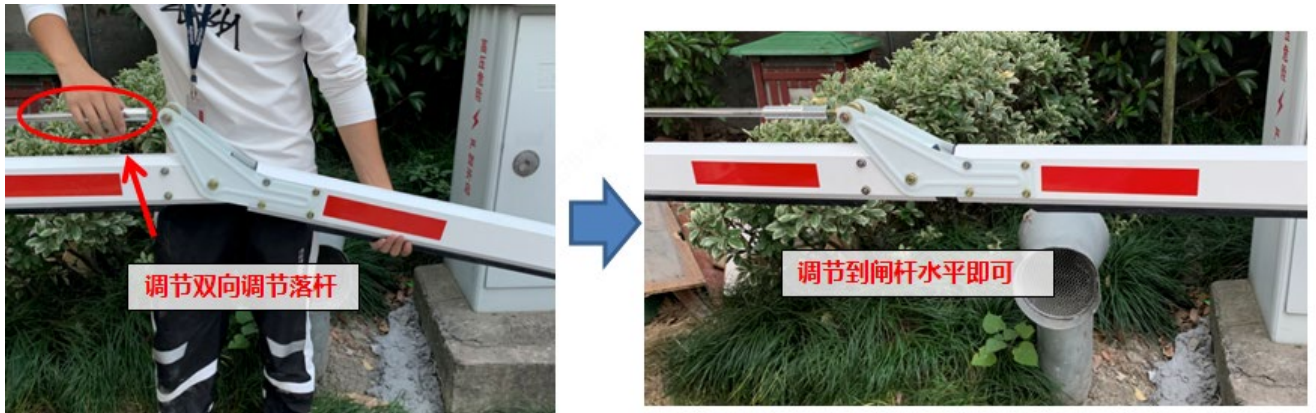
图2-9 曲臂带胶条闸杆调节
