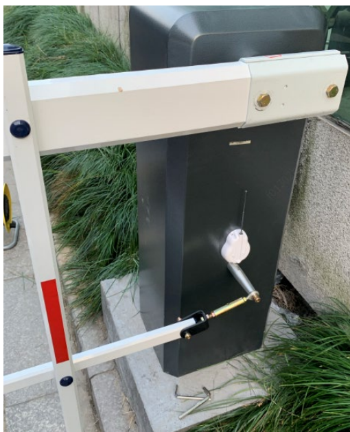
图2-4 栅栏杆安装图片
